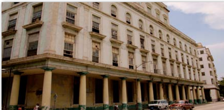
Das Gebäude ist riesig, noch um einiges größer als die Cigarrenpaläste, die ungefähr zwei Jahrzehnte früher gebaut wurden.
